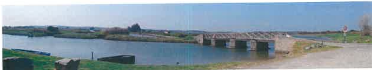
Pont de la Solaire
