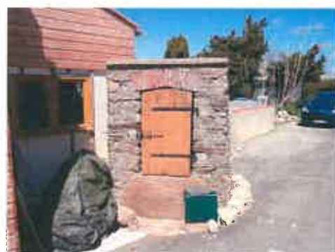
Puits à La Burelière
