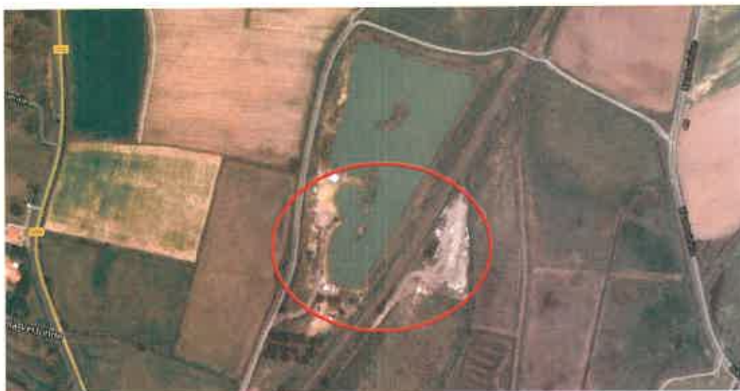
Décharge sauvage le long de la vallée de la Veronne (secteur de zone humide identifiée par le SAGE)
