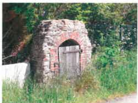
Puits à La Burelière
