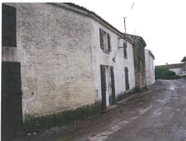
Bâti en alignement des voies
