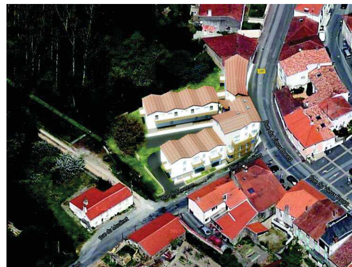
14 logements intermédiaires livrés en 2018 rue du Moulinet (MOA : Podhélia - Moe Axens Architecture)
