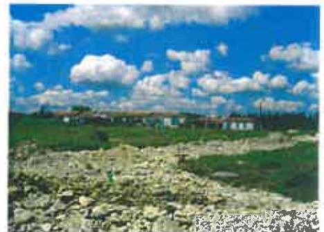
Lotissement en cours entre le logis du Chalusseau et le bourg
