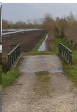
Exemple de pont
