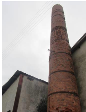
La cheminée de l'ancienne usine du Grand de Mil
