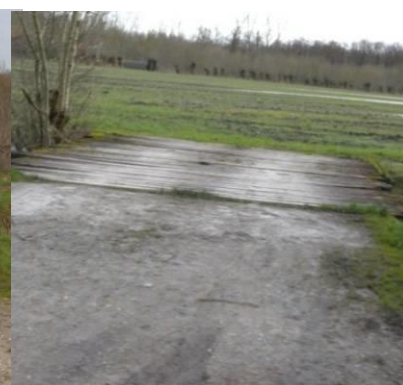
Exemple de ponceau
