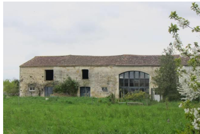
L'ancienne ferme du Cloucq
