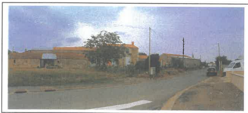
Entrée Sud du Bourg, un bâti relativement serré
