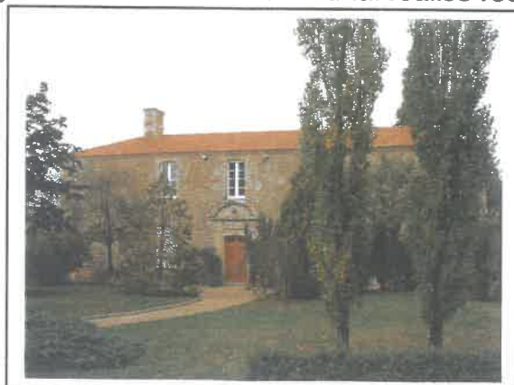
Mairie de Corpe (façade sur Jardin)
