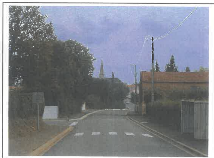
Entre Frosse et Corpe, un linéaire de voirie important : plus de 2 km.
