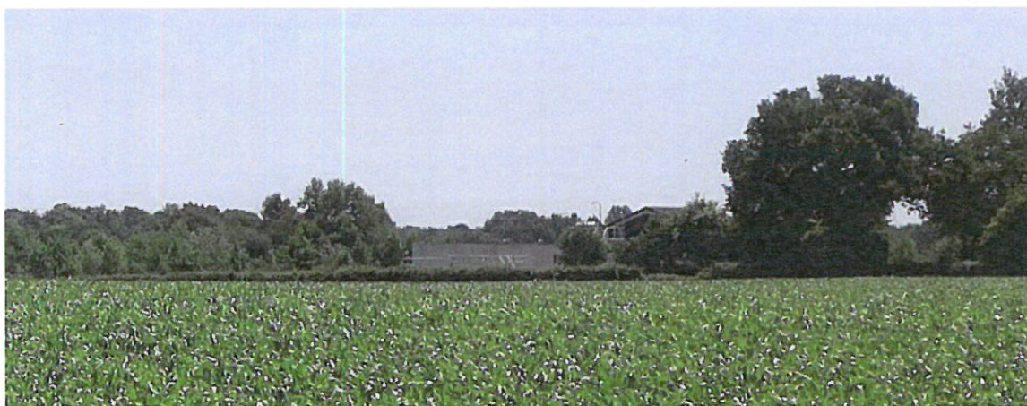
La station d'épuration au Sud de la ZA de la Folie
