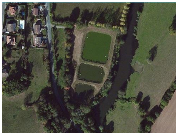
Bassins de lagunage situés l'ouest du bourg →
