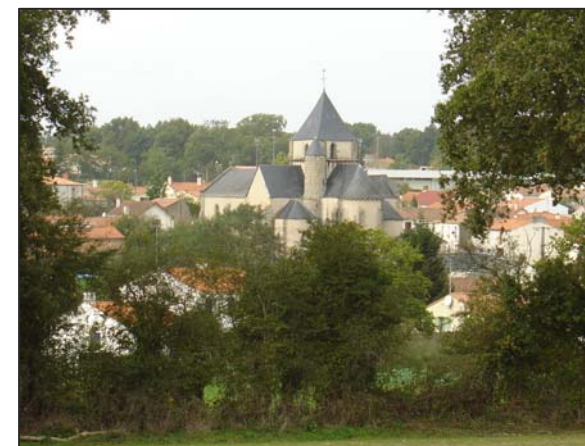
Cône de vue sur l'église d'Aubigny depuis le secteur de la Poiraudière. Au premier plan, la vallée de la Soivre.
