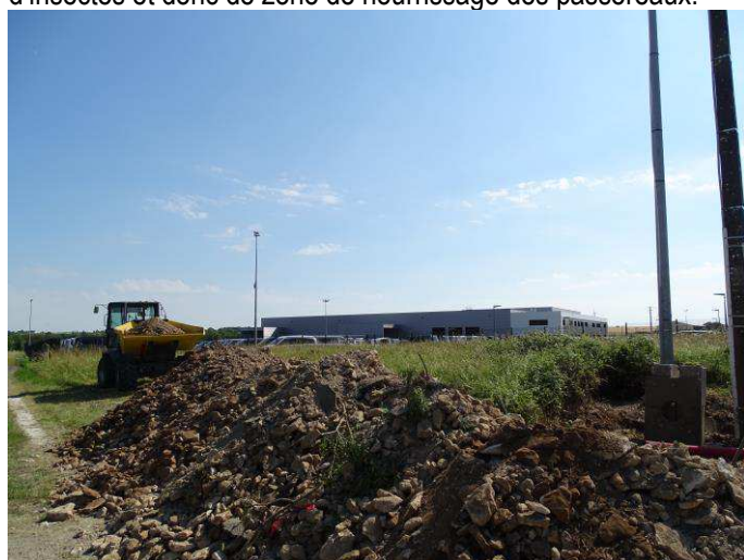
Figure 10 : Vue de la parcelle située au Sud-Ouest (Source : Eau-Méga, juin 2021)
