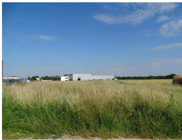
Figure 12 : Vue de la zone depuis le Sud de la parcelle (Source : Eau-Méga, juin 2021)
