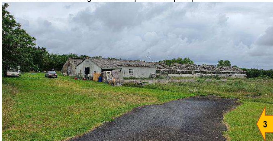
friche agricole : ancien poulailler en cours de déconstruction
