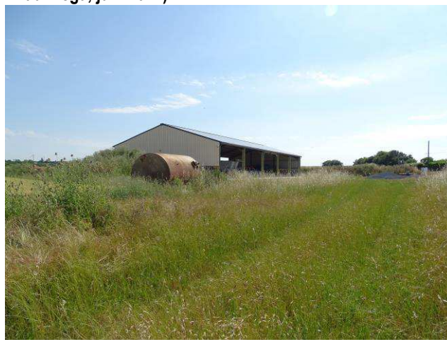
Figure 14 : Vue de la zone vers l'Est (Source : Eau-Méga, juin 2021)
