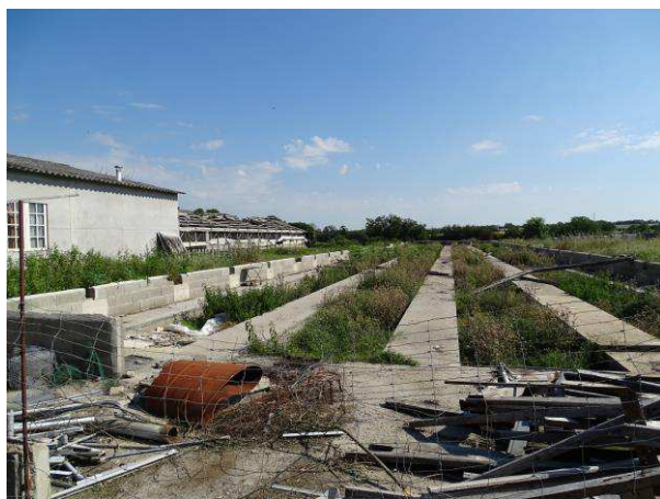
Figure 7 : Vue des bâtiments en cours de démantèlement (Source : Eau-Méga, juin 2021)
