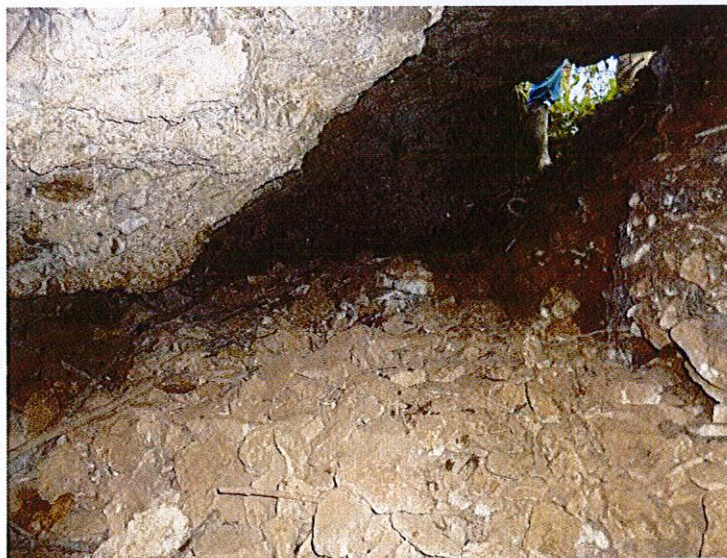
Illustration 10 : Un des accès latéraux, en partie remblayé (site 4)
