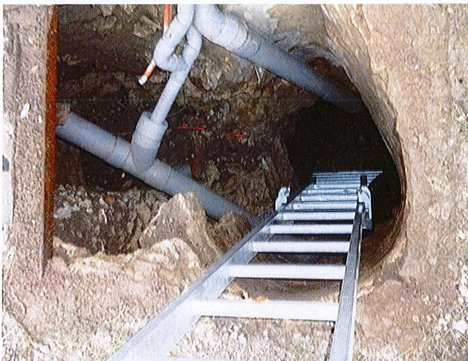
Illustration 4 : Puits d'accès à la cavité du site 2
