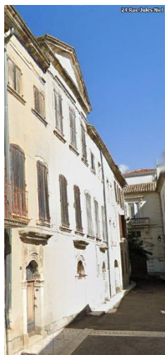
Symétrie des ouvertures, fronton, encadrements de porte, corniches
