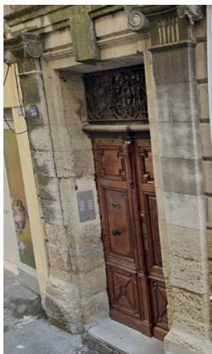
Porte en bois, encadrement et feronnerie en imposte
