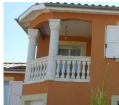
Type de balustres interdits
