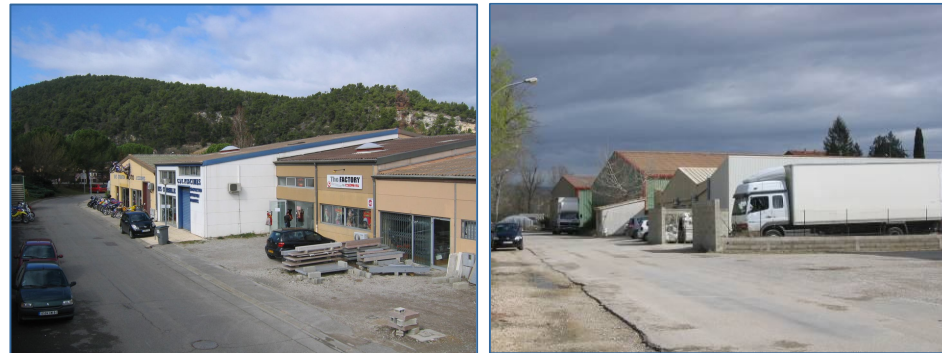
Faiblesse du traitement de la ZA de l'Ouvèze
