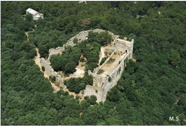
Château du Castellans : ce vieux bâtiment en ruine qui surplombe la commune est susceptible d'accueillir des oiseaux, mammifères, reptiles, etc. (Photo : Mairie d'Uchaux)
