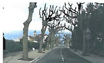
La RD975 à l'entrée Ouest de Travaillan
