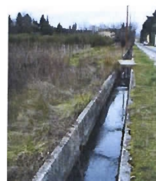
Canal d'Alcyon longeant la RD93
