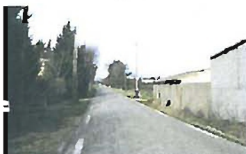
La RD93 entre Le Grand pré et le vieux Travaillan
