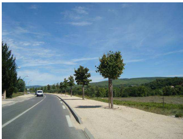
RD956 au Sud du site d'OAP
