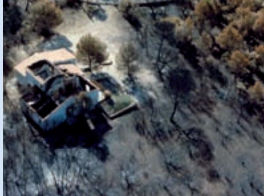
Après l'incendie de Saumane en 1989 (SDIS 84)
