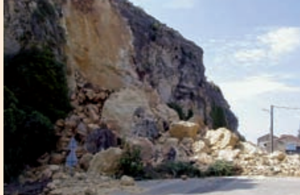
Éboulement sur la RD26 près de Mondragon (DDE 84)
