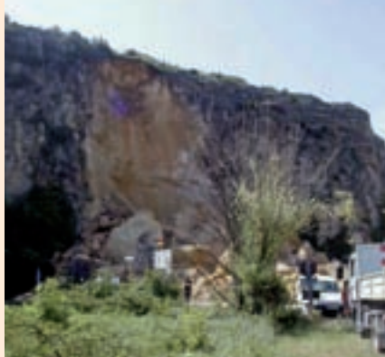
Éboulement sur la RD26 près de Mondragon (DDE 84)
