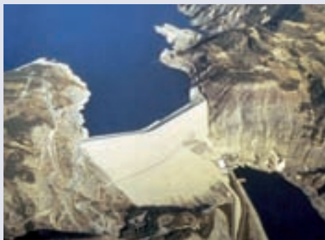
Barrage de Serre-Ponçon (EDF)
