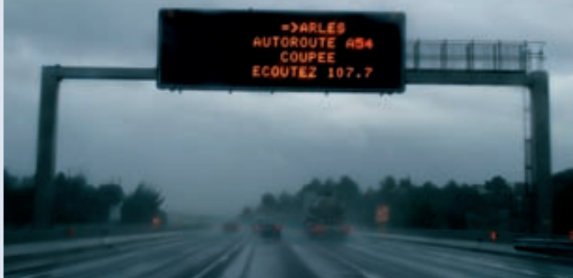
Pluies diluviennes sur l'autoroute A54 – panneaux de signalisation autoroutière (SDIS 84)
