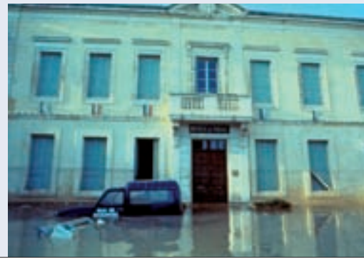
Mairie de Bedarrides, inondation de septembre 2002 (SDIS 84)
