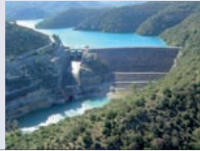
Barrage de Créteux (EDF)
