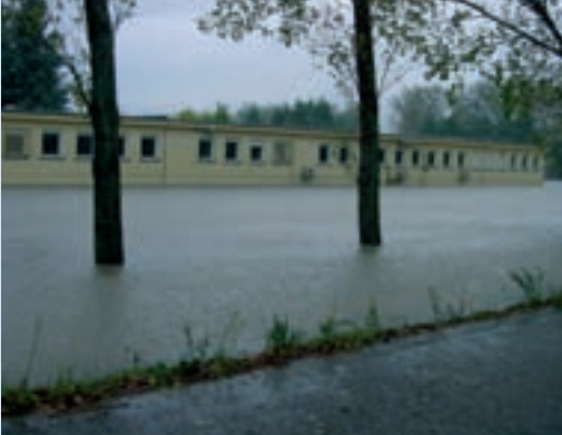
Niveau d'eau atteint sur la base aérienne 115 d'Orange en 2002 (Service des Archives)
