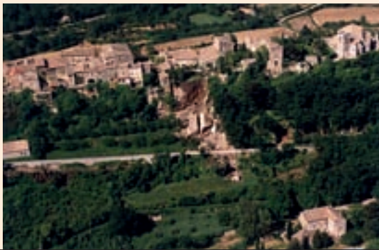
Éboulement à Menerbes (BRGM)
