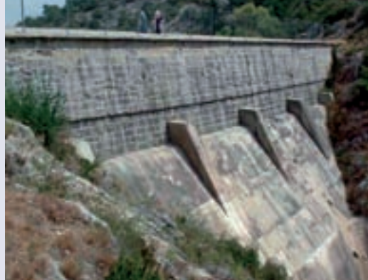
Barrage du Paty (SDIS 84)
