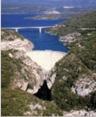
Barrage de Sainte-Croix (EDF)
