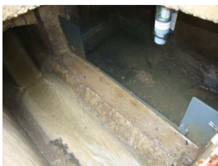
Figure 4 : Exemple de lame déversante
