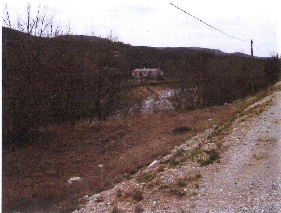
photo 4 : le lit mineur du Calavon se confond avec le lit moyen. On le voit profondément encaissé dans le lit majeur. Les berges portent des traces d'érosion. Un pavillon a été récemment construit en lit majeur, à proximité du cours d'eau.
