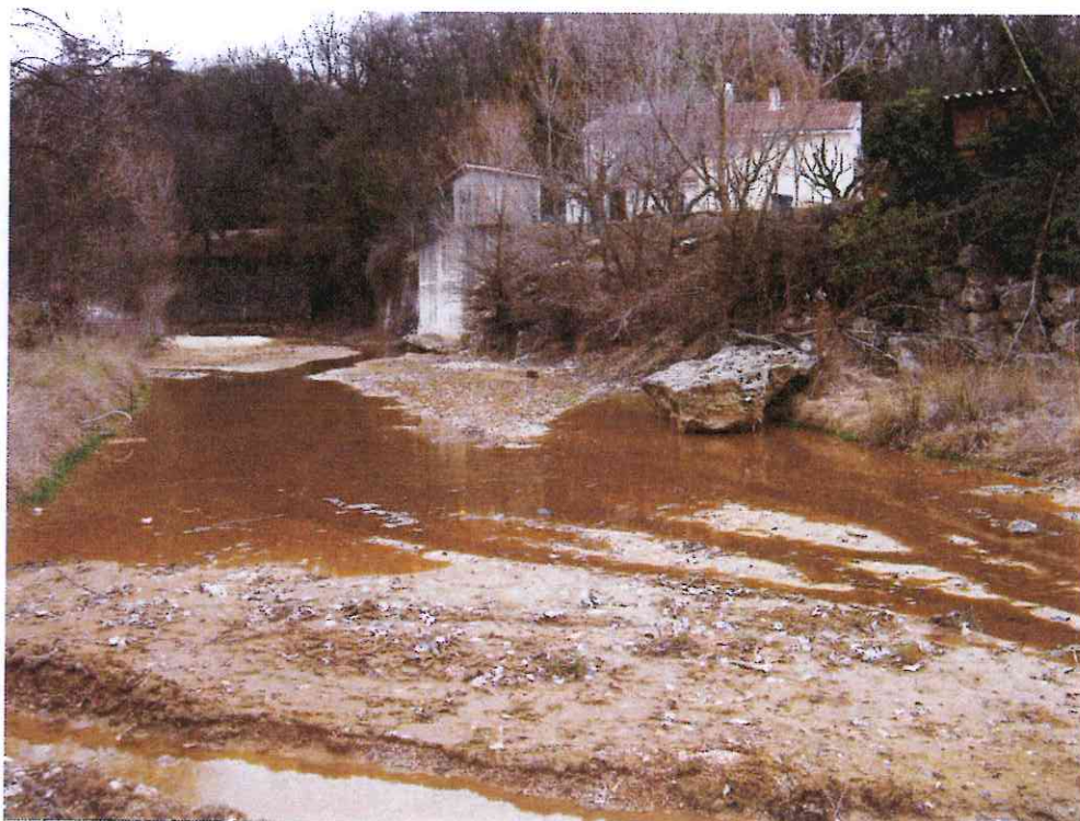
photo 5 : le lit moyen du Calavon dans la partie amont de sa traversée d'Apt et les enrochements qui protègent les berges.
