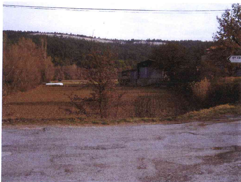
photo 1 : un des bâtiments compris en zone inondable à la confluence avec le Grand Vallat. La photo est prise du remblai du pont de la RD 155 sur le Calavon. A gauche de l'image, on voit la ripisylve qui borde le lit mineur du cours d'eau. Le lit majeur s'étend dans le champs labouré et est limité par un talus net de plusieurs mètres à droite de l'image.
