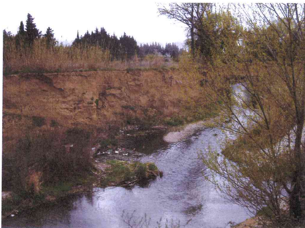
photo 8 : le lit moyen du Calavon à l'aval de Cavaillon. Image prise de la digue rive gauche.
