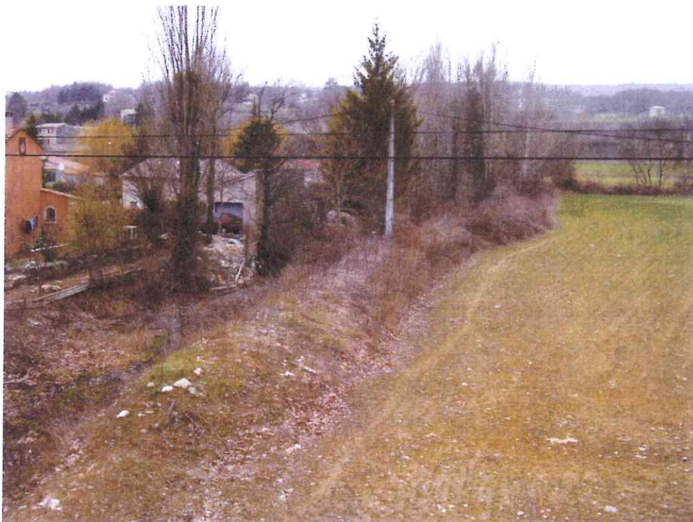
photo 9 : le lit mineur de l'Aiguebelle, le lotissement situé en lit moyen. La digue est en rive droite et protège le lit majeur combiné de l'Aiguebelle et de l'Encrême. En arrière plan on aperçoit le lit mineur de l'Encrême bordé d'une fine bande de ripisylve et son lit moyen qui apparaît dans le champs en vert foncé
