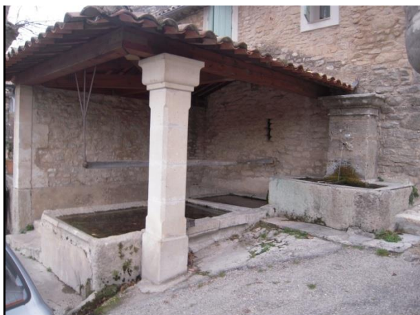
Lavoir et fontaine dans la rue du Quai
