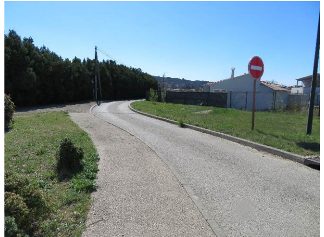
Vue sur le chemin des peupliers (accès nord) (n°14)
