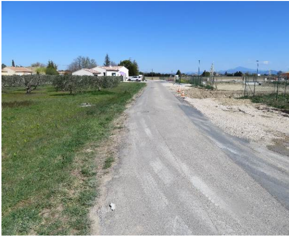
Vue sur le chemin des Peupliers bordant l'OAP au sud (n°1)
