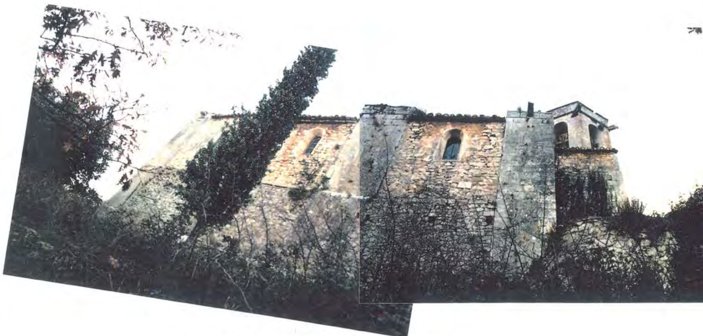
Photo n°30 La façade nord de l'Eglise en contre-plongée.
