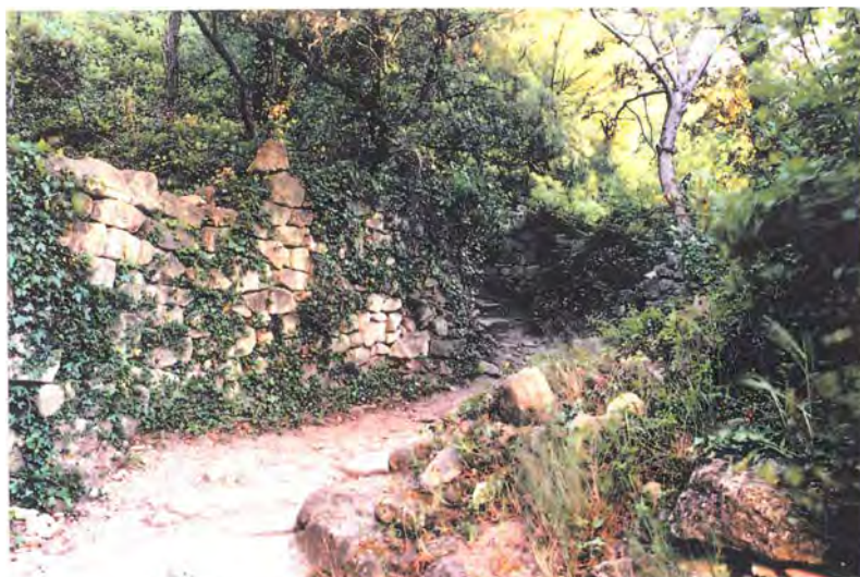
Photo n°25 Entrée du chemin-escalier
