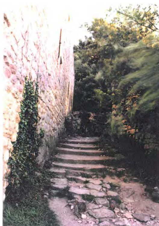
Photo n°24 On longe le mur ouest.
