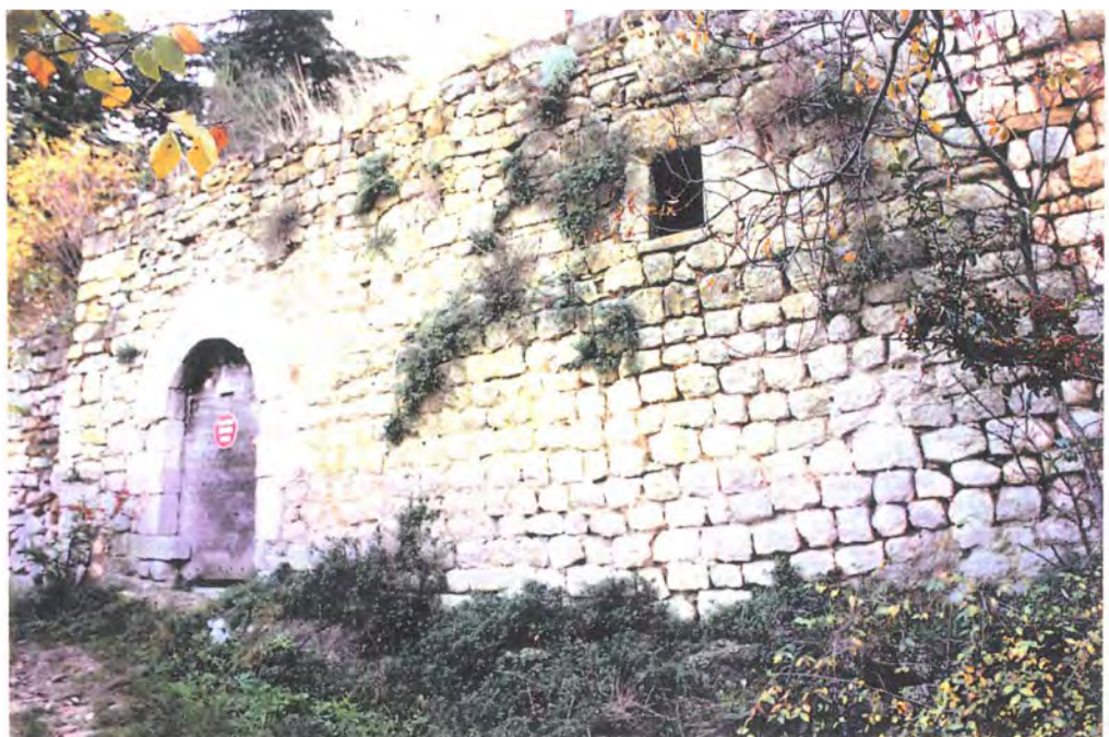
Photo n°21 Le soubassement conforté d'une ancienne maison
