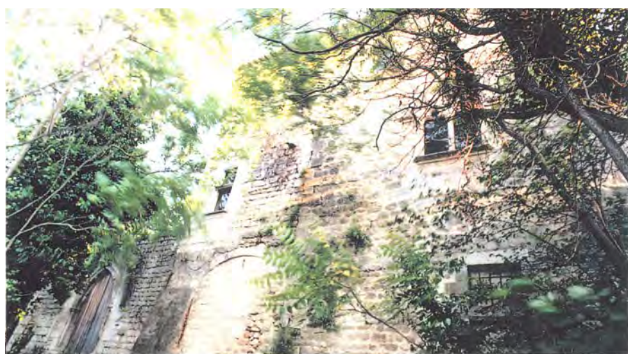
Photo n°13 Partie 3 La façade de la maison restaurée
