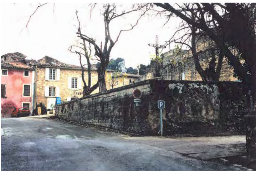
Photo n°13 Le mur de soutènement de la place laisse apercevoir les bâtiments
