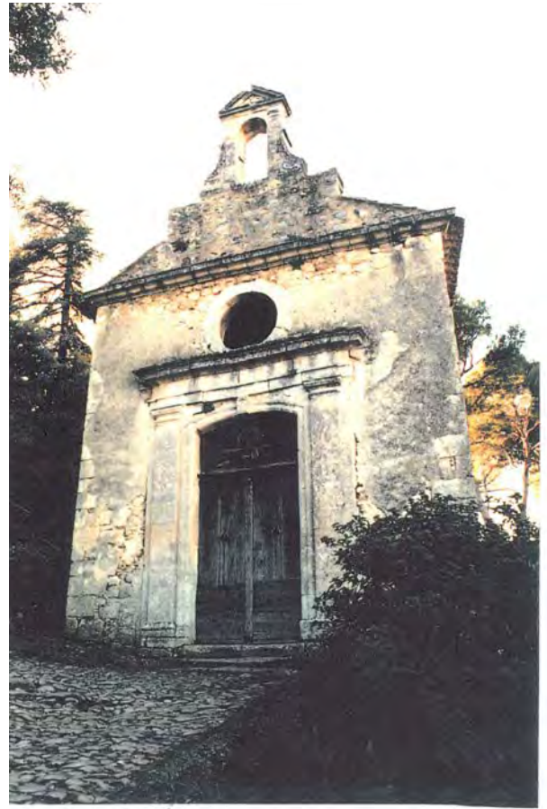
Photo n°17 Découverte de la façade principale
