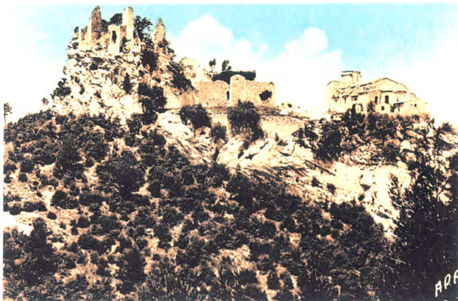
Vue par derrière au début du siècle
