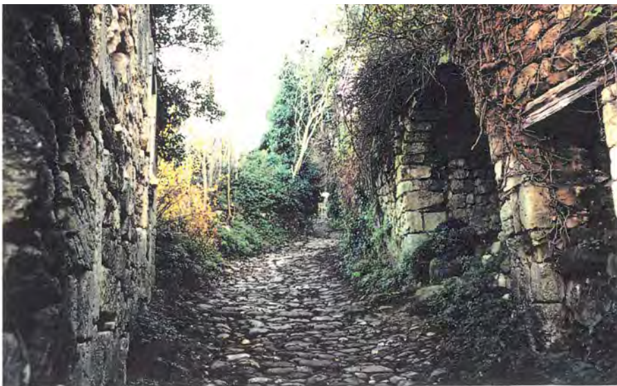
Photo n°10 Partie 1 Passage voûté
