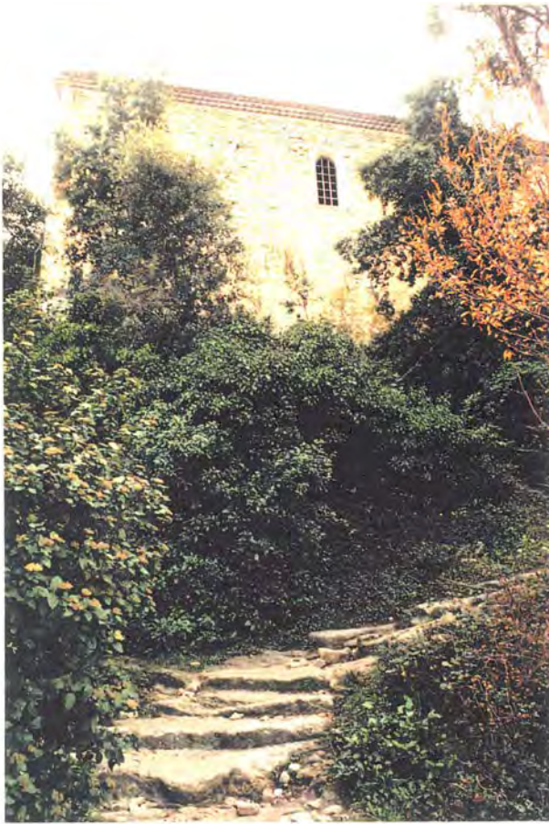
Photo n°15 L'escalier la façade de la chapelle des pénitents
