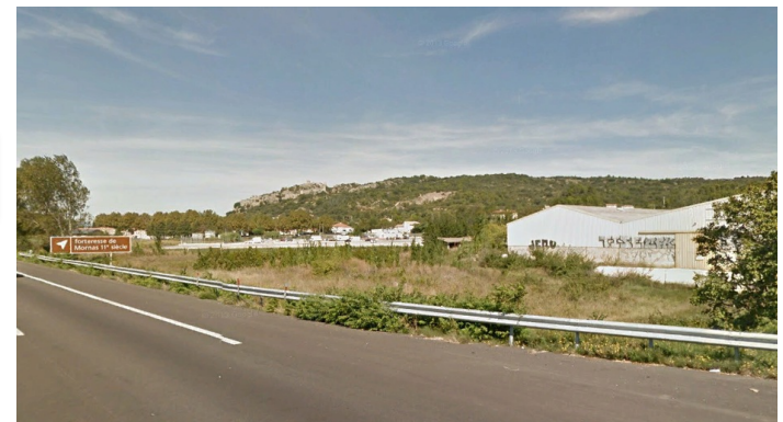
Vue sur le Château depuis l'autoroute A7
