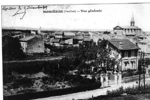
- Autre vue prise du talus SNCF. On distingue au loin l'ancienne horloge et son drapeau.
