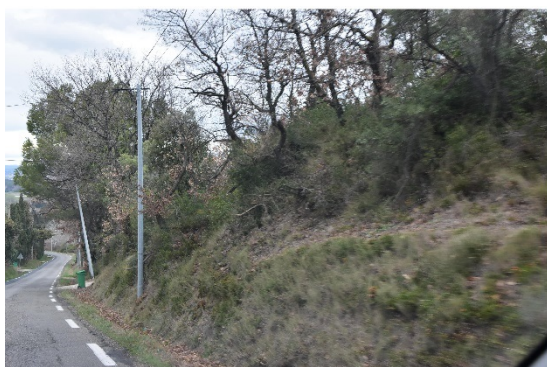
Talus bordier planté le long de la RD 171
