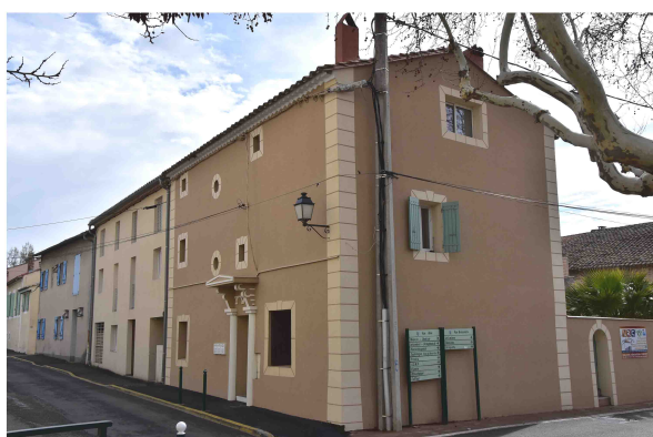
Division d'un bâtiment existant en plusieurs logements
