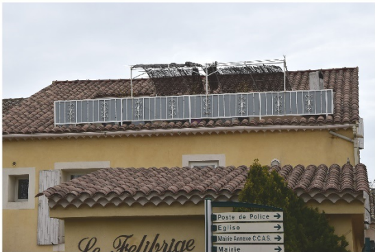
Garde-corps et couverture de la terrasse en toiture
