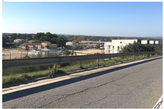
Dégagement visuel au pont sur A7
