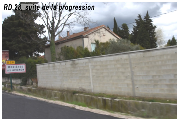
Une succession de murs de clôture
