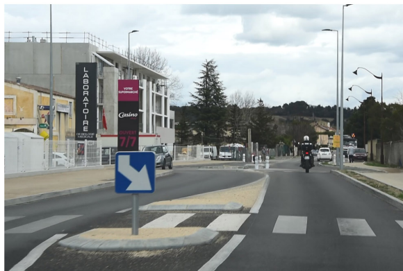
Importante opération de renouvellement urbain
