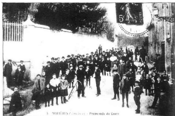
- Tout Morières est là pour la photo, devant la palissade du "château" des de Blanchetti (actuelle école maternelle Agricole Perdiguer).
