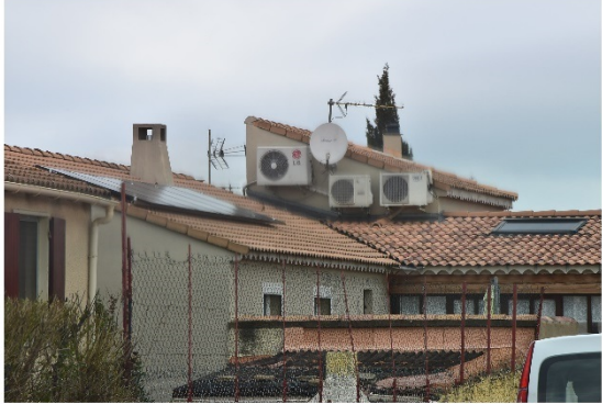
Éléments techniques multiples
