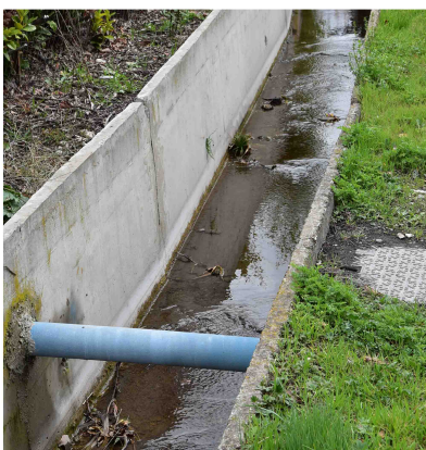
Ouvrage de gestion des eaux, avenue du 8 mai 1945
