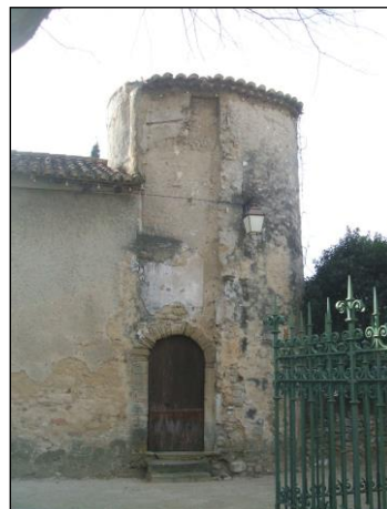
Tour et escalier de l'ancien château de Sade (parcelle CA 101, ex O 697)
