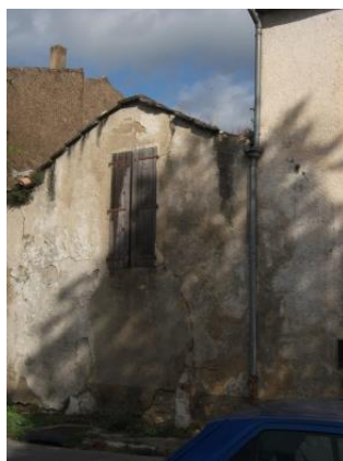
Toit en lauses de l'ancienne chapelle de St Sébastien (15 e siècle), CC 248
