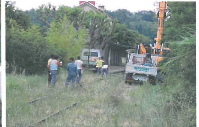
Les travaux sur la Via Venaissia.
