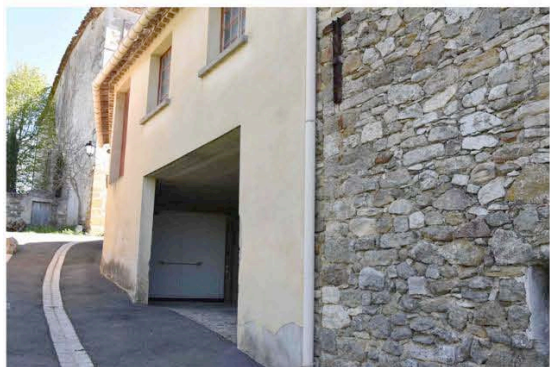
Modifications des ouvertures, enduit
