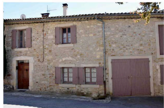
Maison de village (remaniée) avec remise
