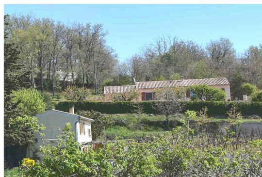
Une extension récente du village entre RD 112 et RD 22
