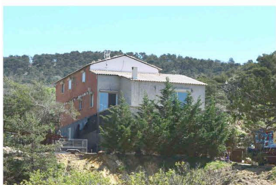
Construction isolée sur coteau, remaniée, impact visuel
