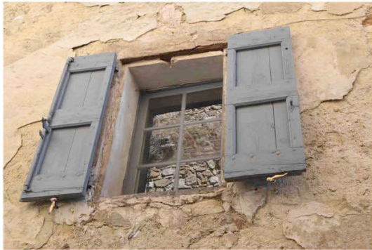
Petits carreaux et volets pleins en bois
