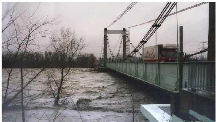
Pont de Pertuis, janvier 1994
