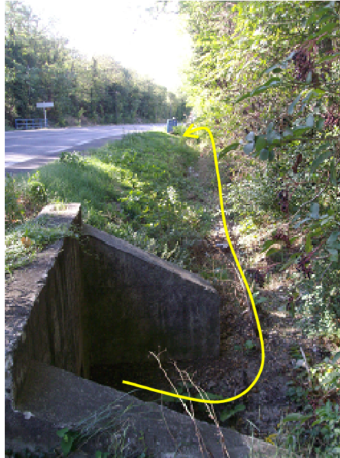
Figure 25 : fossé à l'aval du franchissement de la RD26
