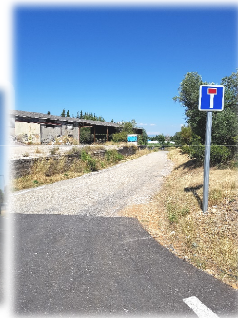
Ancienne RD 66 (voirie de desserte interne potentielle)
