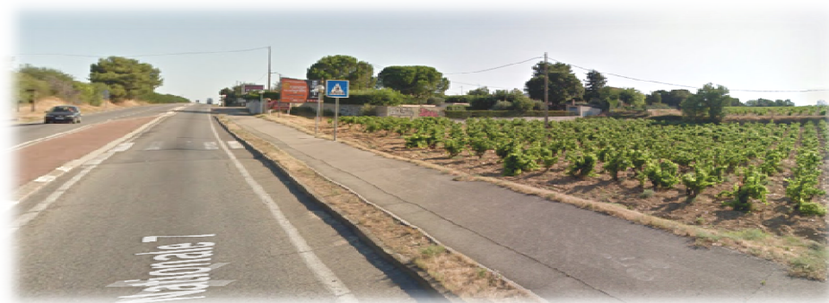
Tronçon cyclable en bordure de la RD907
