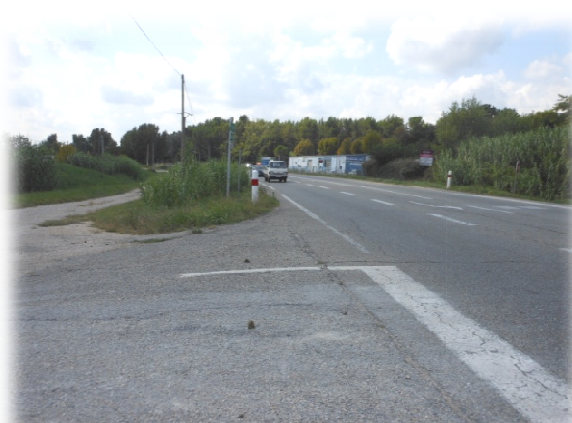
Deuxième accès à la zone
