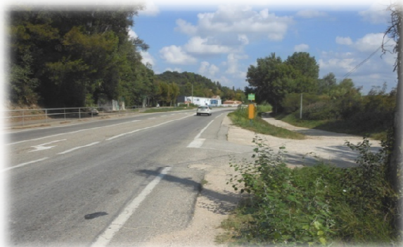
Premier accès à la zone (le plus au Sud)
