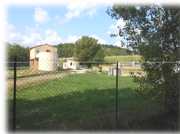
Station d'épuration au Nord de la zone
