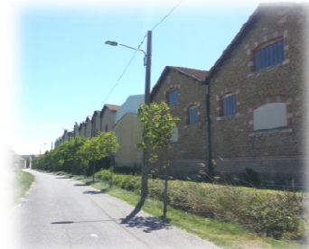
Ancienne usine Canissimo : site à reconvertir
