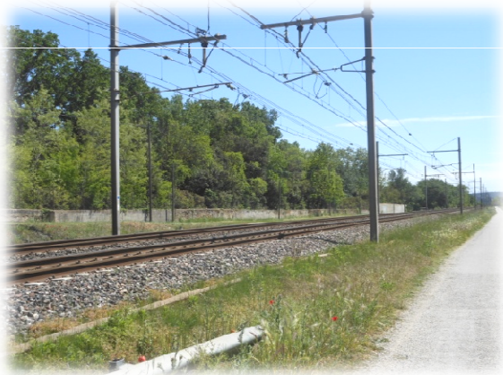
Effet de coupure urbaine induit par la voie ferrée
