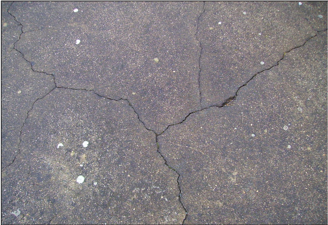
Figure 4-29 : Zoom sur une fissure de la dalle recouvrant la bâche de 700 m 3 - 21 mai 2012
