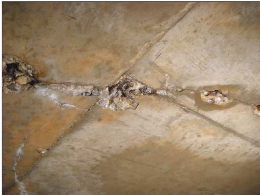
Figure 4-29 : Zoom sur une fissure de la dalle recouvrant la bâche de 700 m 3 - 21 mai 2012
