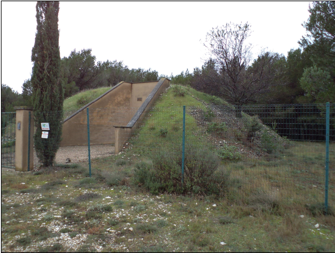
Figure 4-20 : APS n°3 – Réservoir La Chapelle – Cuve existante
