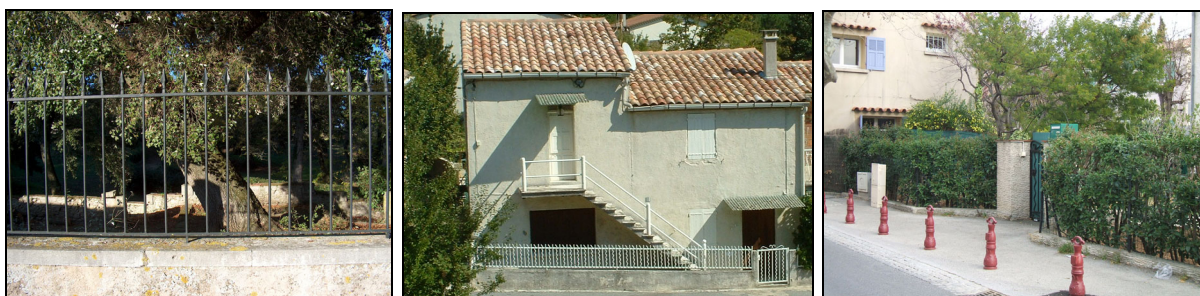
Exemple de clôture autorisée sur domaine public
