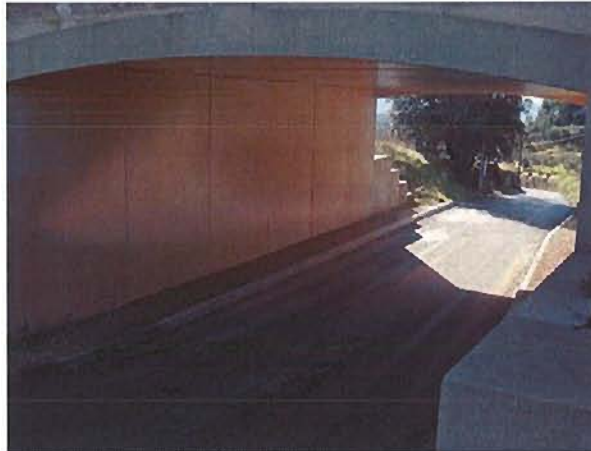
Franchissement de la D973 au Sud-Ouest du village
