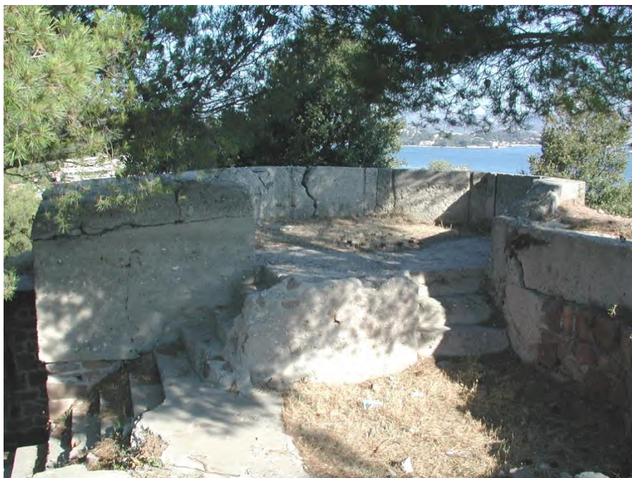
Ouvrage du patrimoine militaire témoin de la défense de la Rade de Toulon
