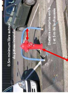
BARRIERE DE PROTECTION D'UN POTEAU D'INCENDIE - Schéma de principe -
