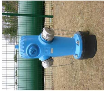
Poteau d'aspiration de 150 mm, muni de deux sorties de 100 mm et d'un carré de manoeuvre
