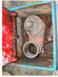
Bouche Incendie de 80 mm à raccord Keyser
