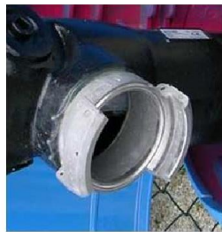
Poteau d'aspiration de 100 mm, muni d'un raccord fixe de 100 mm, avec raccord fixe
