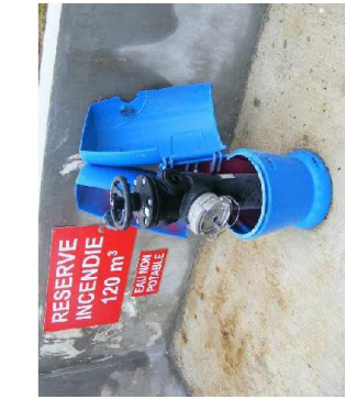
Poteau d'aspiration de 100 mm, muni d'une seule sortie de 100 mm et d'un volant de manoeuvre
