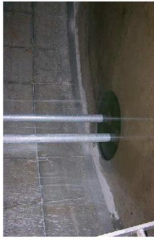
Fond de la cuve avec crépine sous le niveau le plus bas de l'eau
