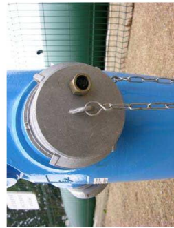
Poteau d'aspiration de 150 mm muni d'un Airclap
