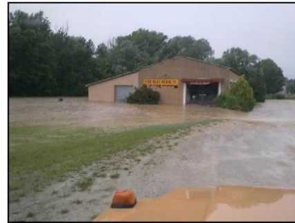
Figure 17 : Inondation des Meubles Belouin – 15 juin 2010
