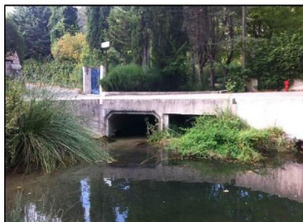
Figure 21 : Ouvrage hydraulique du Vallon de l'Hôpital, boulevard Charles Bernard.
