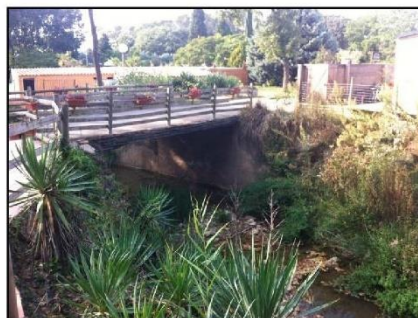
Figure 15 : Ouvrage de franchissement hydraulique à l'entrée du Camping du Ruou
