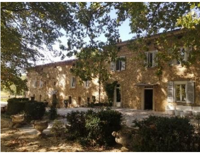
Vue Sud du 1 er bâtiment
