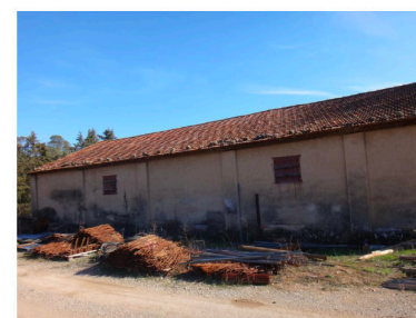
Bâtiment F : Le hangar
