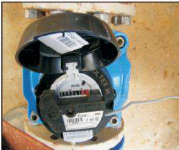
3. Vue du dispositif de comptage et sa tête émettrice
