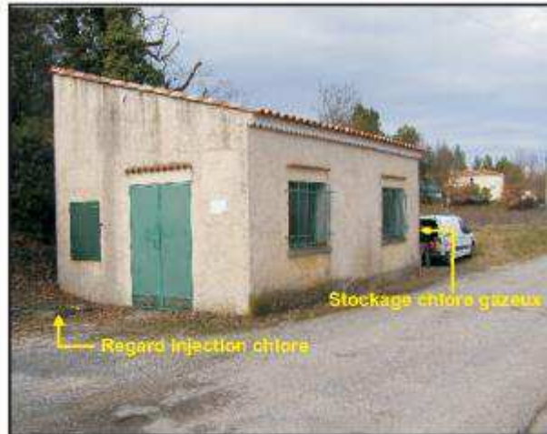
1. Vue extérieure de la station de surpression
