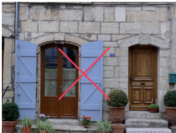
Harmonie des teintes de menuiseries inversée (à proscrire)
