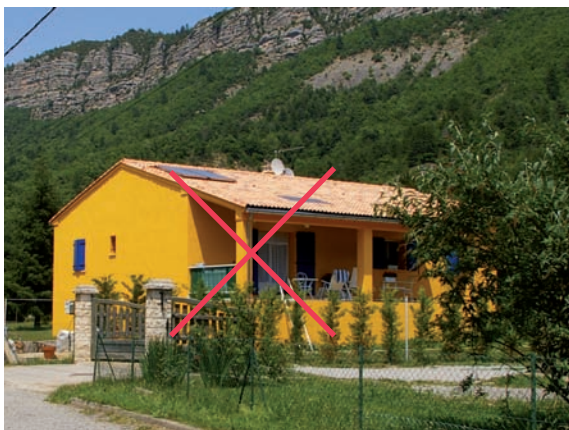
Enduit de teinte trop soutenue (à proscrire)
