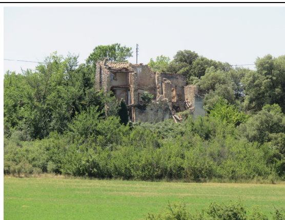
117. Ruines au nord de ND d'Eglise, parcelles 755, 756, 757 et 1479
