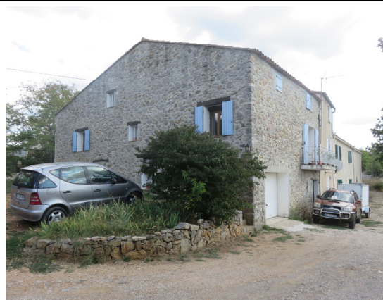
8. Ancienne ferme, Lieudit Les Benets, parcelles 375, 672 et 671
