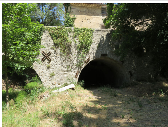
110. Pont sur la RD30 avec lavoire en-dessous, vallat du Pont
