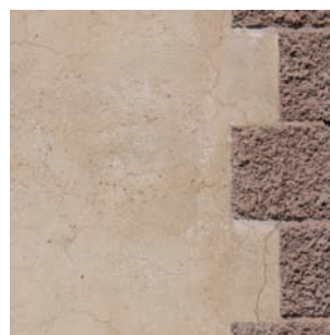
Décor de chaîne latérale harpée enduite à la tyrolienne à finition grenue formant un fort contraste de teinte et de texture (Montagnac-Montpezat)
