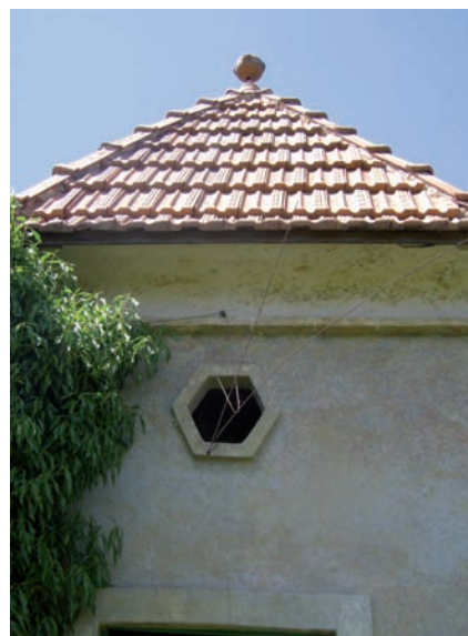
Tuiles plates mécaniques (cabanon à Riez)
