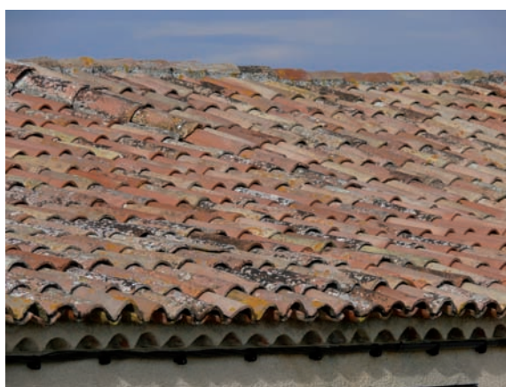
Tuiles rondes de teinte rosée dominante en pan de toiture et en faitage (Ginasservis)
