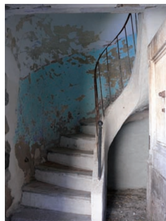
Escalier intérieur tournant à jour central, avec garde-corps en fer, nez de marches en bois et revêtement en carreaux de terre cuite
