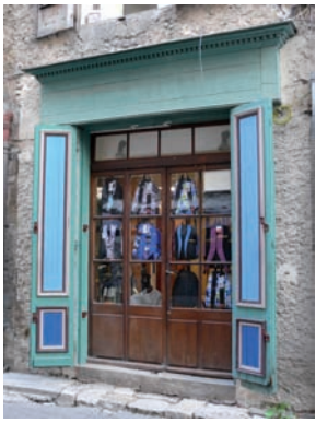
Devanture à bandeau en coffrage de bois surmontant une vitrine à petits bois pouvant être fermée par des vantaux repliables (Riez)
