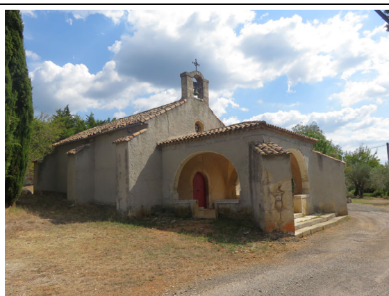
1. Eglise Saint Roch, Lieudit Saint Roch, RD 554
