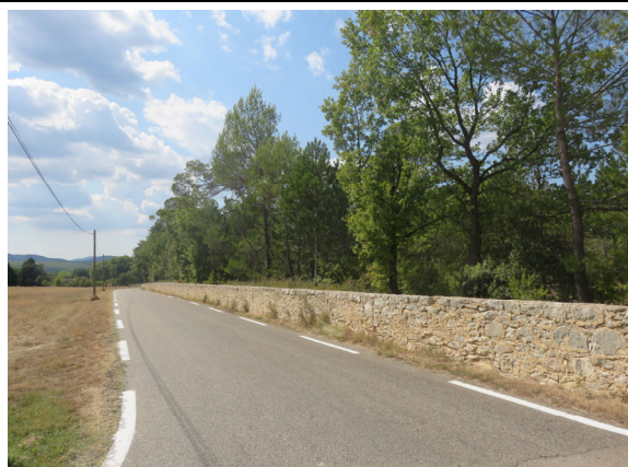
112. Le mur le long de la RD 30, lieudit Notre Dame
