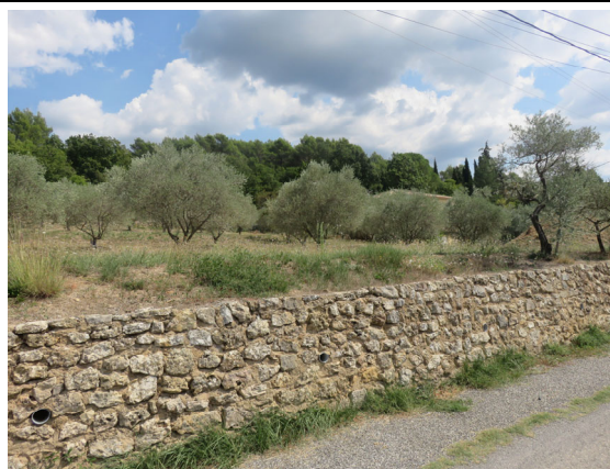
113. Restanques sur l'ancien chemin de Varages
