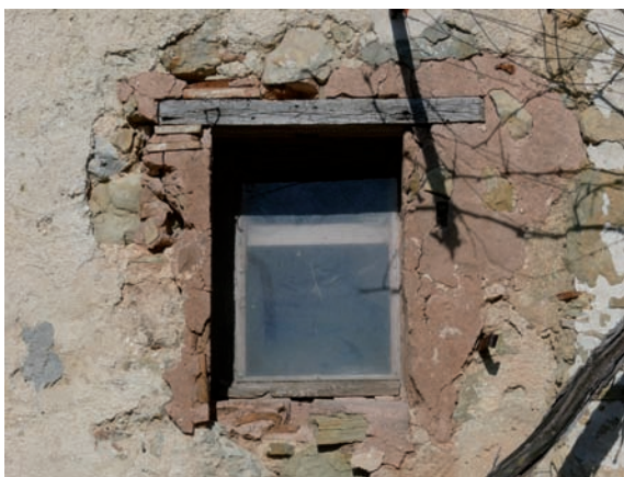
Feuillure de fenestron en mortier de plâtre fortement cuit de teinte rose (Peyroules)
