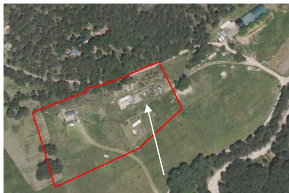
Travaux entamés il y a 33 ans en 1985
