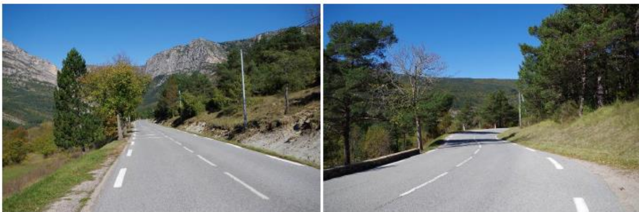
Vues 3 et 4 - La route RD955 est large et sa trouée laisse en permanence entrevoir les reliefs au loin.
