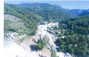
Photos 70 : La Nartuby secteur Granegone – Post Crue
