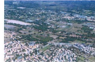
Photos 20 : L'Argens au niveau du pont de Roquebrune - Au fond secteur des Garillans - Post crue
