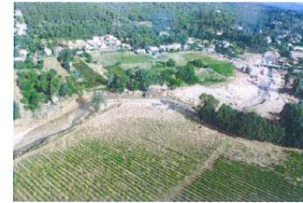
Photos 36 : Aval et pont de la RD10 – Florièye à Taradeau - Post crue
