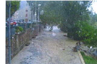
Photos 112 : Trans en Provence centre – Post Crue
