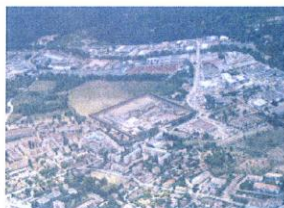
Photos 83 : La prison de Draguignan – témoin de zone d'écoulement – vue décruce DREAL
