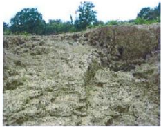
Photos 121 : Travertins de la Motte mis à nu au niveau de l'ancienne route des Arcs
