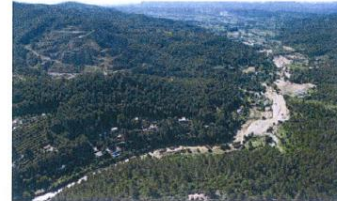
Photos 71 : La Nartuby secteur Granegone Vallon de Tunis – Post Crue
