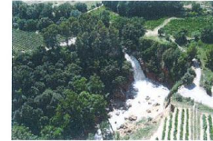
Photos 124 : Saut du Capellan - Vue post crue
