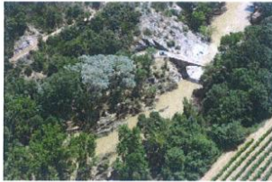
Photos 10 : Pont de la Tournaelle –Gorges de l'Argens en aval des Arcs – Post crue
