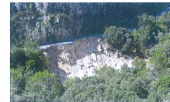
Photos 63 : La Nartuby dans les Gorges – RD955 coupée en plusieurs points – Post crue
