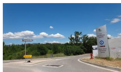
↳ Entrée de la zone d'activités des Ferrages (en arrière-plan, le site étudié)
