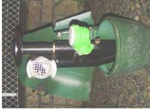
Intérieur d'une borne de puisage avec le raccord de 65 mm et compteur d'eau
