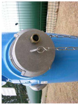
Poteau d'aspiration de 150 mm muni d'un Airclap
