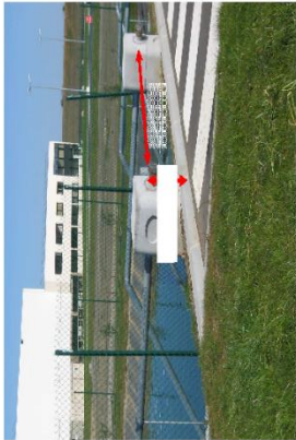
Plat forme d'aspiration sur une réserve d'eau équipée de deux colonnes d'aspiration de 100 mm
