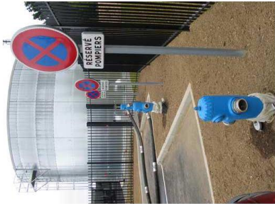
Réserve d'eau incendie aérienne de 720 m³ équipée de 3 poteaux d'aspiration de 150 mm
