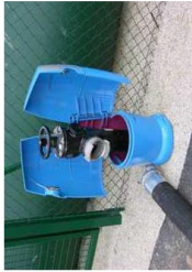
Poteau d'aspiration de 100 mm
