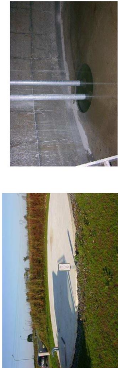
Fond de la cuve avec crépine sous le niveau le plus bas de l'eau
