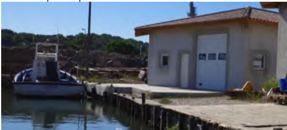
photographie du port de la coopérative aquacole : les quais en bois au premier plan ; au second plan : quais soutenus par des palplanches métalliques avec poutre de rive et plateforme en béton, cliché W&A 2013
