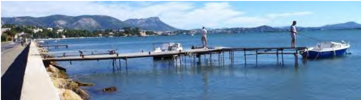
appontement sur pieux en tubes métalliques le long du Croûton, cliché W&A 2013
