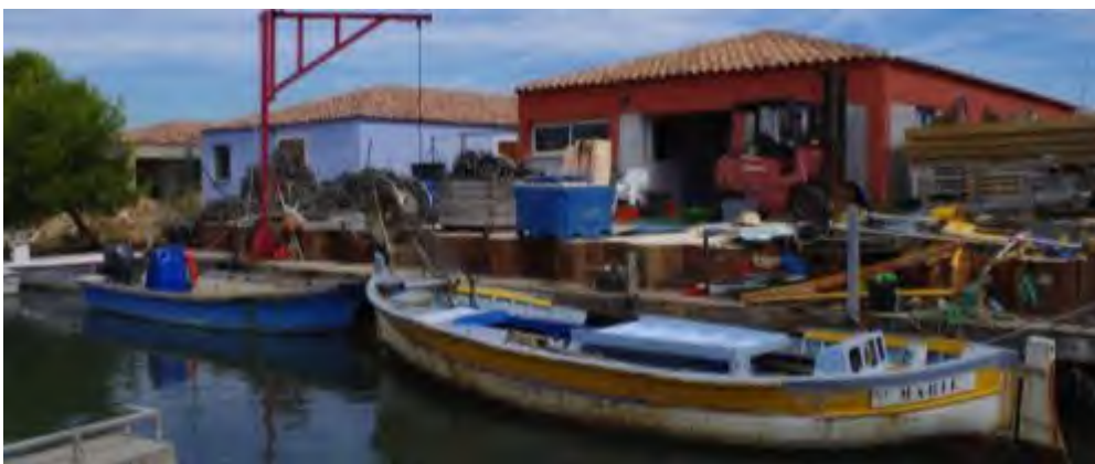
photographie du port de la coopérative aquacole : quai soutenu de palplanches métalliques et béton et en contrebas, appontements en bois, cliché W&A 2013
