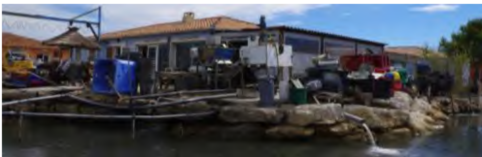
photographie du port de la coopérative aquacole : mas terrestre d'une exploitation conchylicole, la machine qui sépare, brosse et calibre les coquillages a été ramenée à terre, les extensions se multiplient sans pouvoir contenir l'activité initialement prévue, cliché W&A 2013
