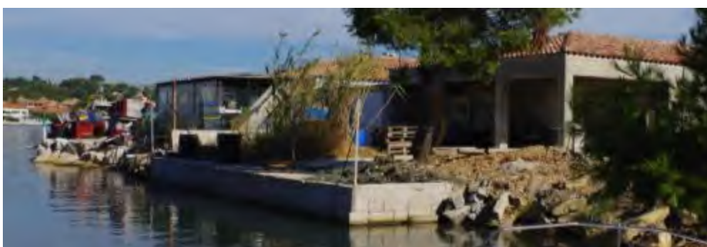
photographie du port de la coopérative aquacole : quai monté en parpaing et enrochements, cliché W&A 2013
