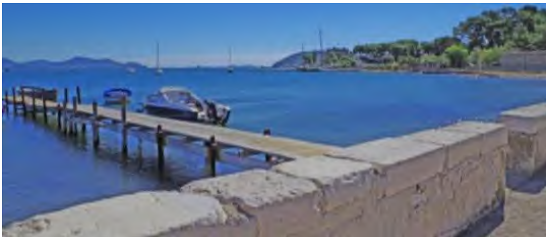
appontement sur pieux en bois et ouverture dans le parapet en pierre (anse de Balaguier), cliché W&A 2013
