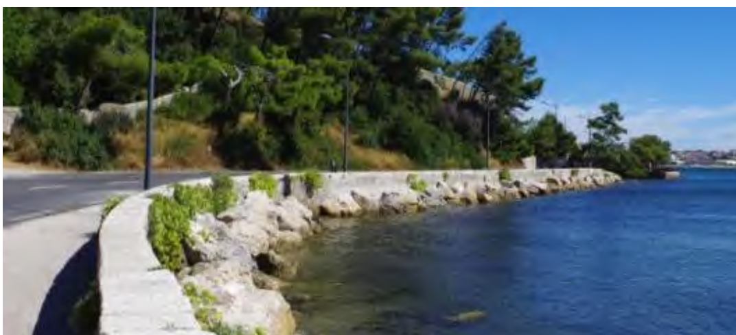
photographie du parapet à proximité de l'Eguillette, cliché W&A 2013
