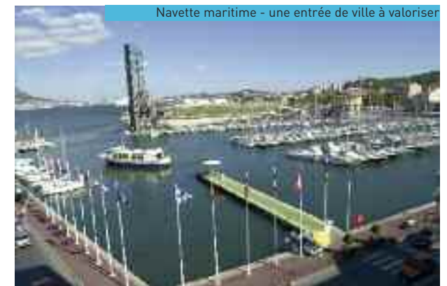
Navette maritime - une entrée de ville à valoriser
