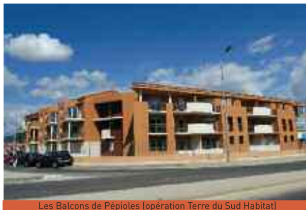
Les Balcons de Pépioles (opération Terre du Sud Habitat)
