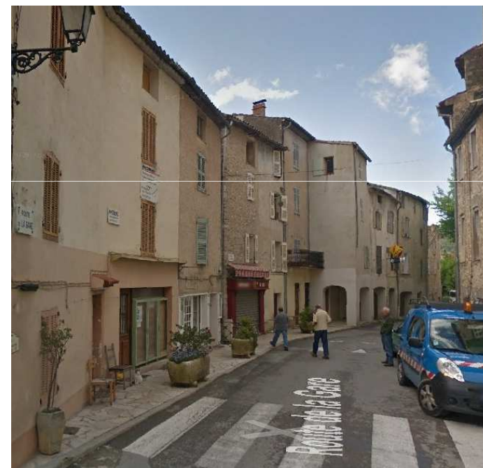
Aménagement des RDC d'immeubles dans le centre
