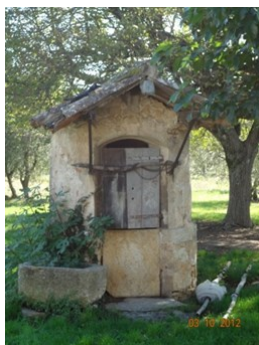
Puit de Trestaure
