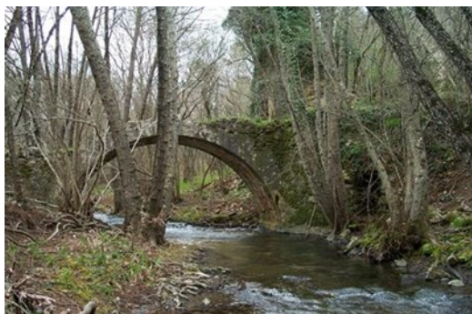
Pont sur l'Endre
