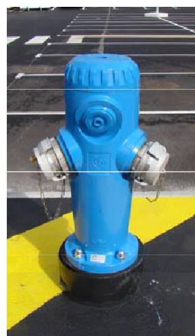
Poteau d'aspiration à réseau sec de 150 mm, muni de deux sorties de 100 mm et d'un Airclap. Pas de carré ni de volant de manœuvre
